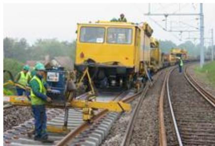
Longs Rails soudés sur traverses béton
